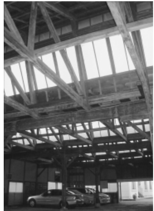
桐生で一番桁行が長い、4連のノコギリ屋根の桐生絹織株式会社。織機が減った現在、西側部分は駐車場として利用している
