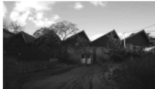
(写真 11) 建設当初からの 5 連部分
