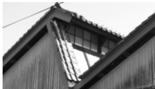
(写真2)傾斜の採光窓の上に垂直の採光窓がある事例
