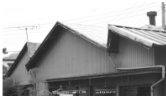
(写真9) 1連+切妻+1連のノコギリ屋根工場
