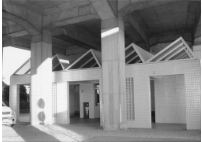
高架下という立地が残念な公衆トイレ
