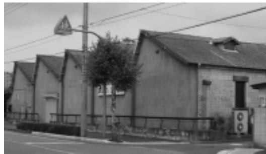
(写真7) 混構造の事例2(外壁は石とモルタル)
