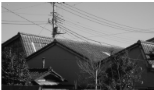
(写真8) 2連+切妻+1連のノコギリ屋根工場
