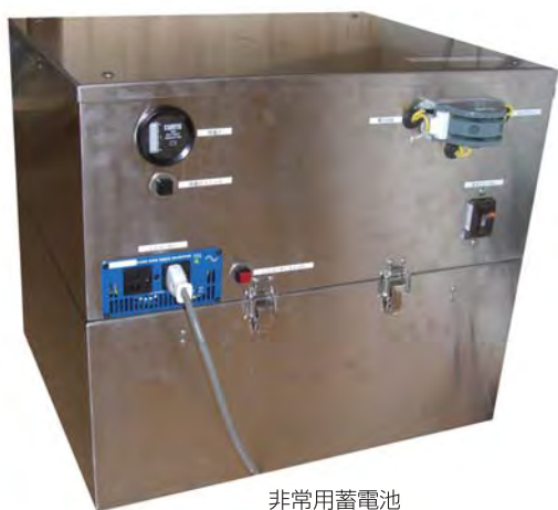
非常用蓄電池
